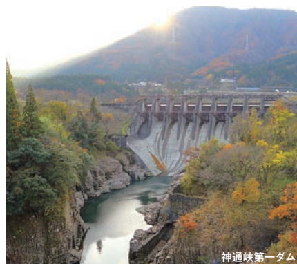
神通峡第一ダム
