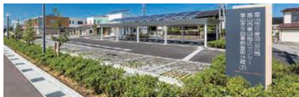
環境や防災に配慮した豊田地区センター公民館
